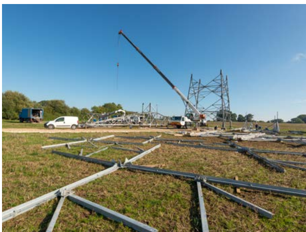
Construction d'un pylône pour la liaison 400 kV Lonny-Seuil-Vesle
