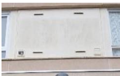
Entrées d'air sur façade
